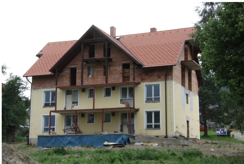
Obrázek 1: Rozestavěný objekt v části Slupečná Zdroj: archiv autorky
