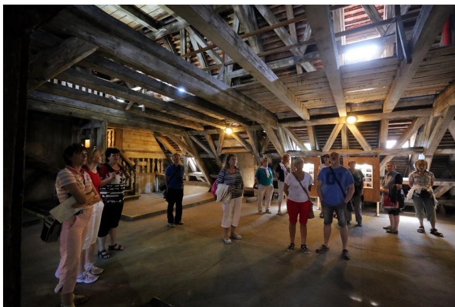
Obr. 5: Barokní krov chebského domu čp. 478, kde začíná prohlídkový okruh
